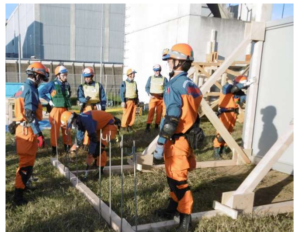
訓練でのショアリング(木材による建物安定化手法)への助言
