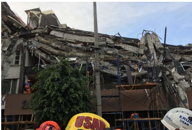
写真10 現場② アルバロ オブレゴン 286 7 階建ての店舗・各種学校等
