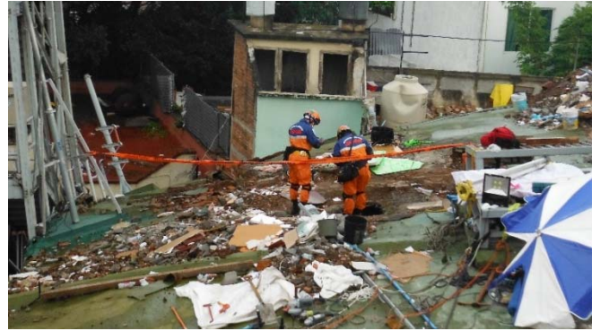
写真12 屋上より搜索中
