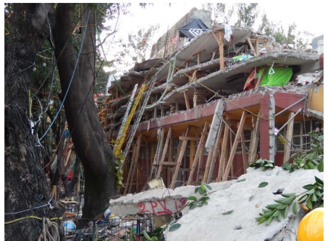
写真 17 現場③ トラルパン 6 階建ての集合住宅
